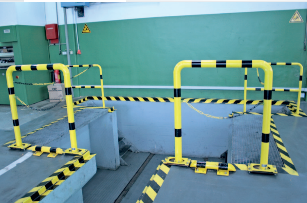
Durch den Umbau wurden die Arbeitsgruben verlängert und der Arbeitsplatz breiter gestaltet
